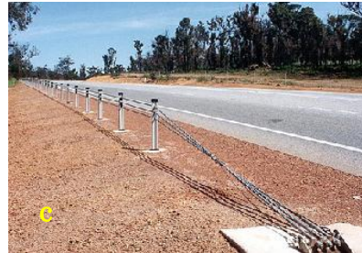
写真-4 車両用防護柵端部構造の例
