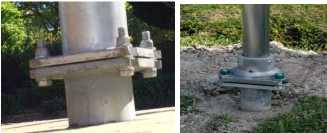
写真-1 柱の切断構造部分
