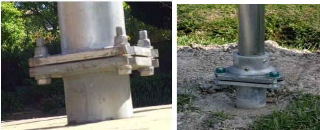
写真-1 柱の切断構造部分
