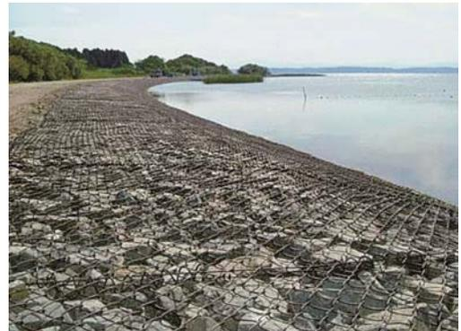
図-2 合成樹脂被覆鉄線の鉄線籠への適用例
