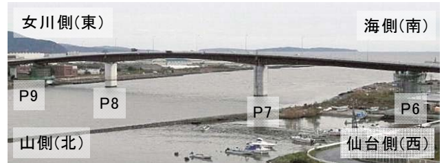
写真-1 日和大橋（中央径間部）
