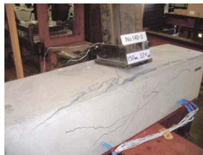
写真-1 地覆破損状況（150mm変形時の例）
