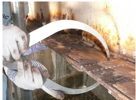
写真-4 キャリパーによる板厚計測例
