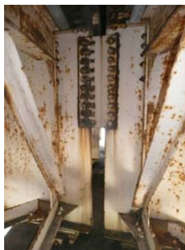
写真-6 耐震連結板
