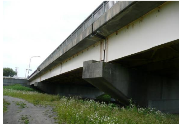
写真-1 上部工腐食状況
