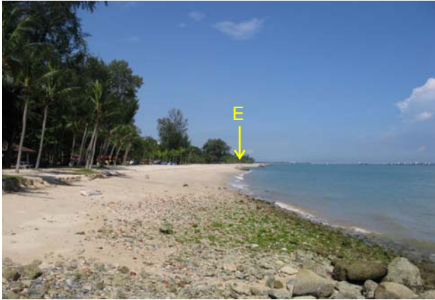
写真-11 排水路Fの東側隣接部での著しい侵食痕跡
