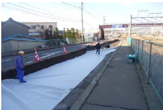
写真-1 ジオテキスタイルの軟弱路床面への敷設
