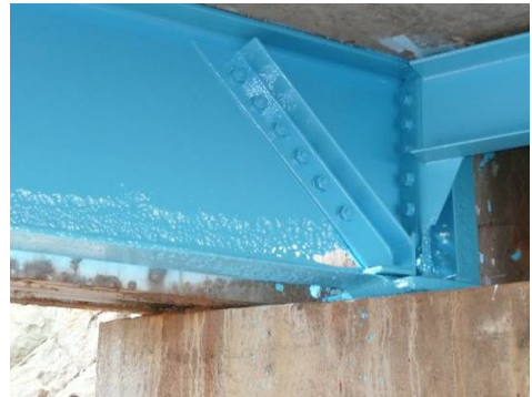
写真-5(2) 補修塗装の施工状況
