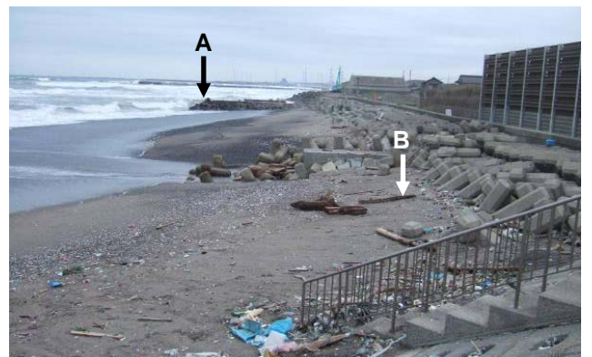
図-6 異常波浪襲来後の2006年11月23日の海岸状況
