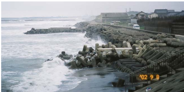
図-4 2002年9月8日（潮位：T.P.+0.7m）における海岸状況
