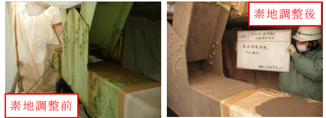
写真-4 素地調整前後外観
