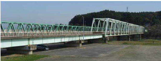
写真-1 橋梁の概観
