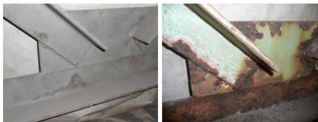
写真-7 素地調整後の比較
