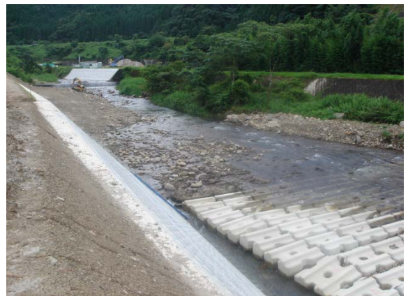
写真-5 河岸侵食対策 2t型 (ブロック上流側敷設)
