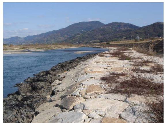
写真-7 低水河岸侵食対策 2t型 (根固め工)
