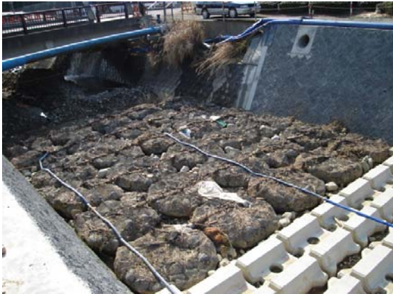
写真-8 河岸侵食対策 2t型 (床固め工)
