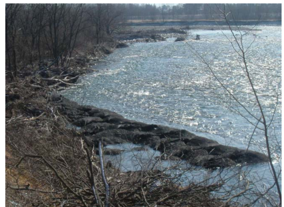
写真-6 河岸侵食対策 4t型 (根固め工)
