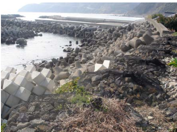
写真-9 法面侵食対策 3t型 (被覆ブロック背面間詰め用仮設材)
