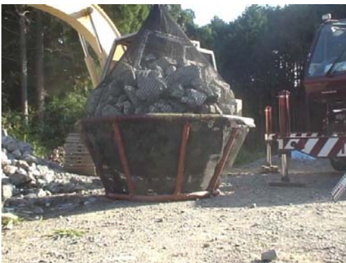
写真-3 吊り上げ状況
