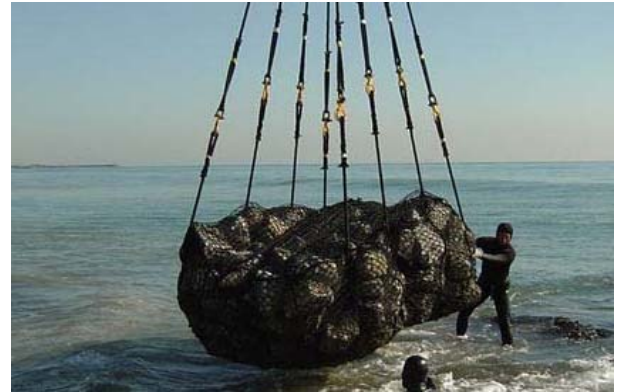
写真-12 箱形袋体 10t型 (施工状況)
