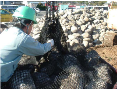
写真-2 口縛り状況
