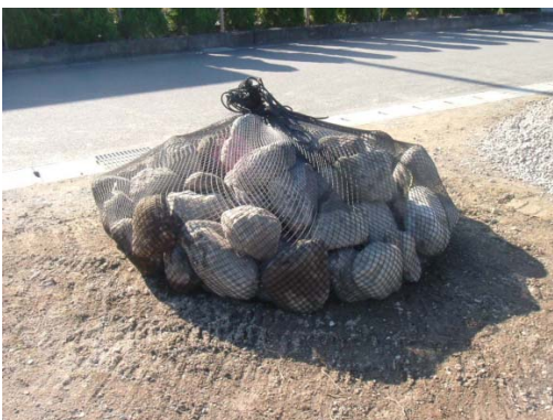
写真-4 仮置き状況
