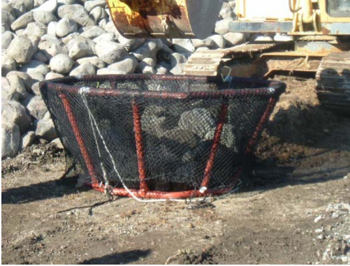
写真-1 中詰め材の投入状況
