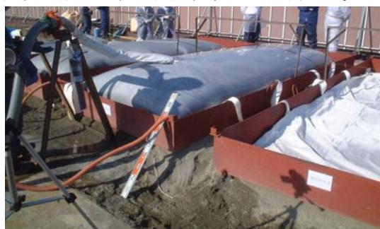
写真-3 鋼製の仮設台での充填状況
