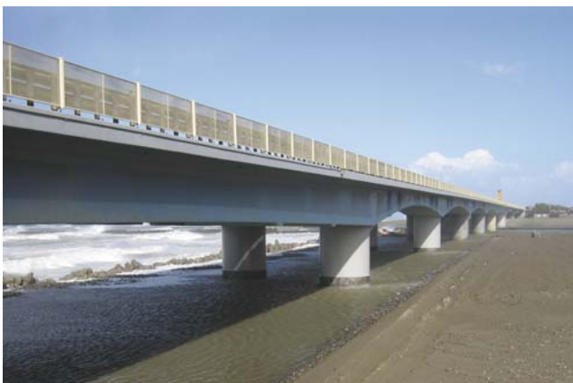
写真-1 UFCの橋脚への適用例 (橋脚下部にUFC製のパネルを設置)
