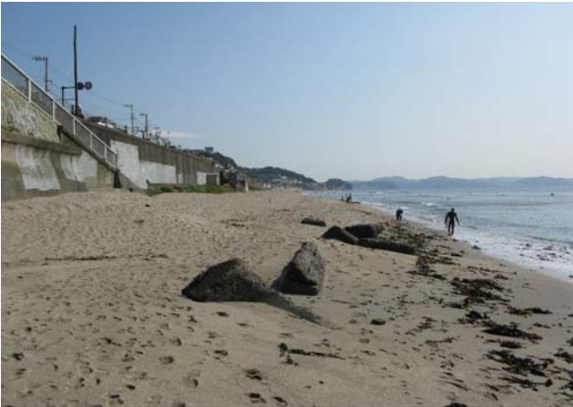
写真-3 階段付近の海岸状況
