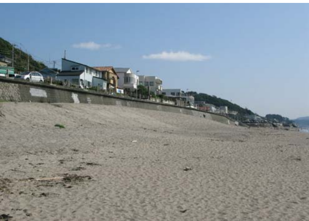
写真-4 隅角部のA付近の海浜状況
