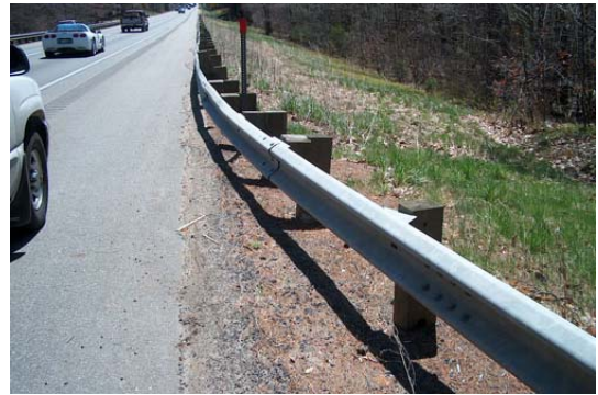
写真-1 支柱に木材を使った防護柵の例 2)
