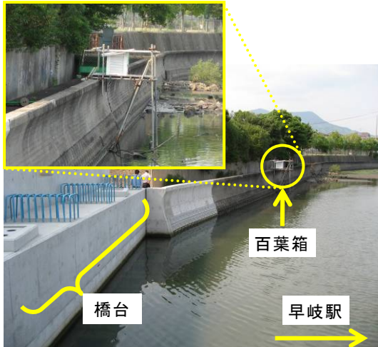
写真-2(1) 百葉箱設置状況
