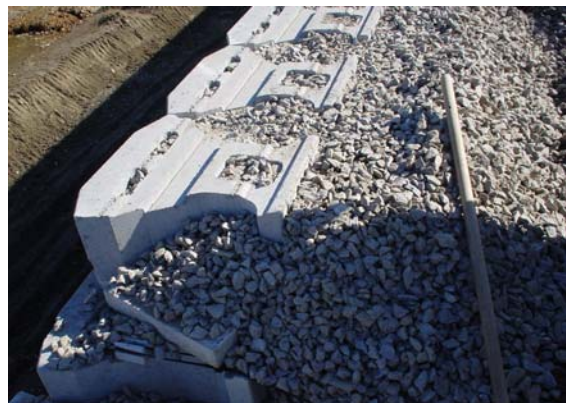
写真-4 ブロック形式の壁面工
