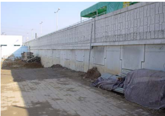
写真-6 補強土壁（ウェルソブ工法）
