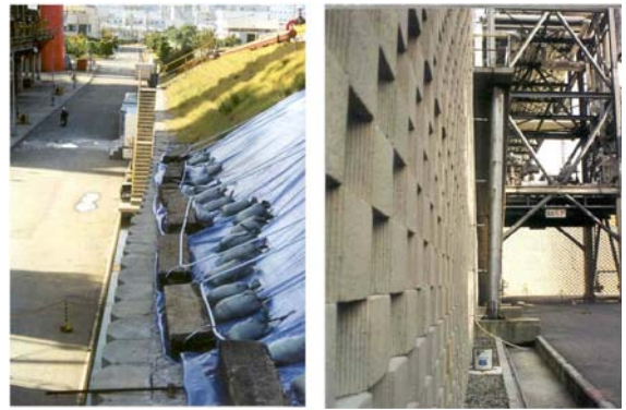
写真-1 補強土壁の崩壊事例
