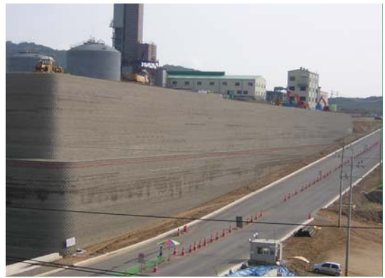
写真-3 大規模補強土壁の施工過程
