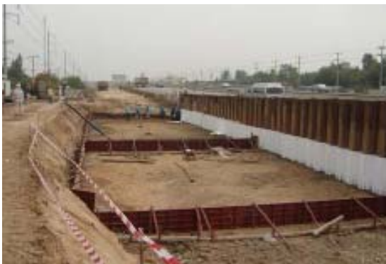
写真-4 基礎掘削状況
