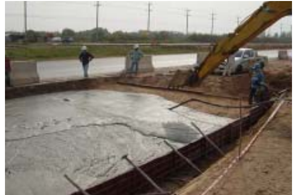
写真-6 気泡混合土最終打設状況
