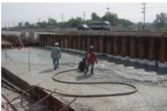
写真-5 気泡混合土打設状況
